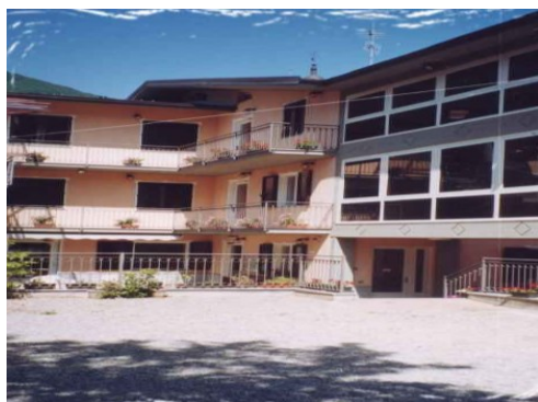
Struttura di Entracque
