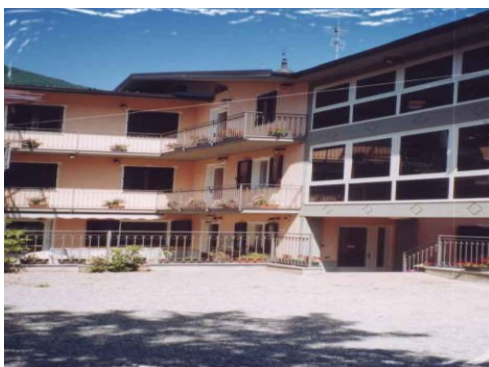
Struttura di Entracque
