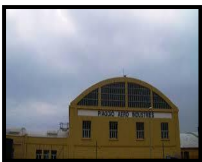
Hangar Piaggio di Finale Ligure.
