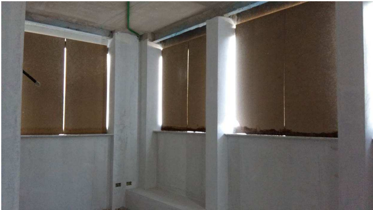
Foto 5) Locali interni. Intonaci e arenini realizzati
