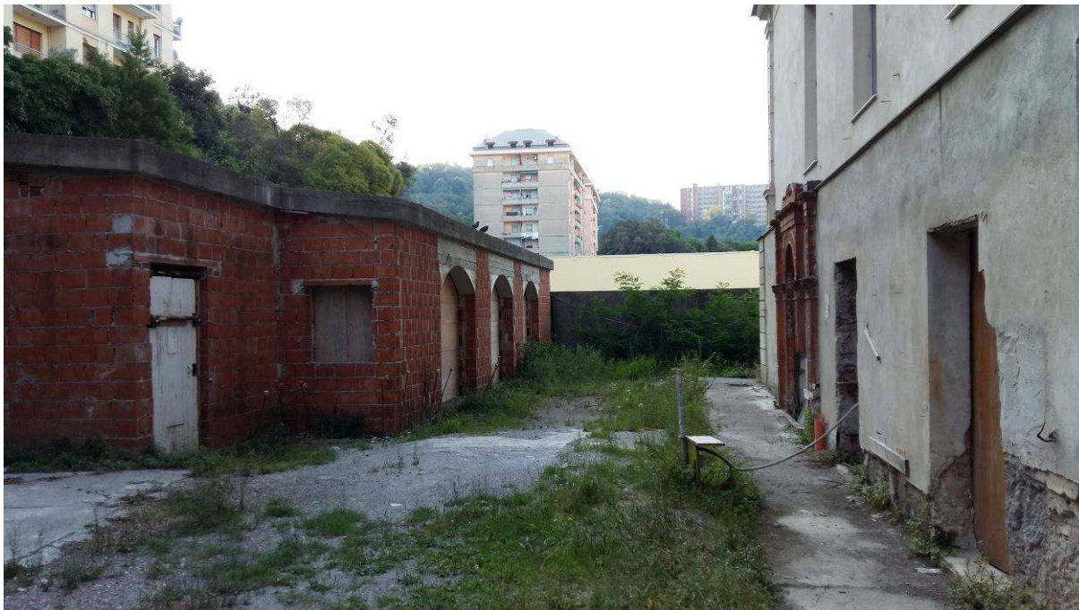
Foto 3) Prospetti lato est e manufatti esterni con protezioni e pannellature.
