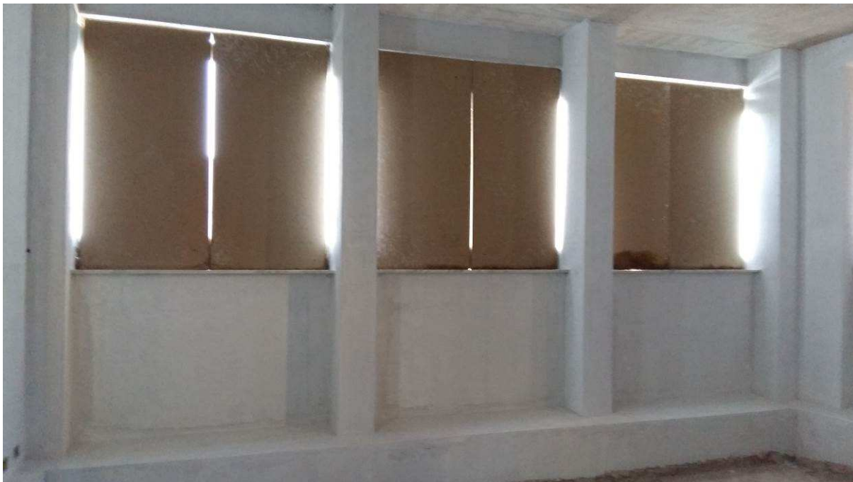
Foto 6) Locali interni. Intonaci e arenini realizzati
