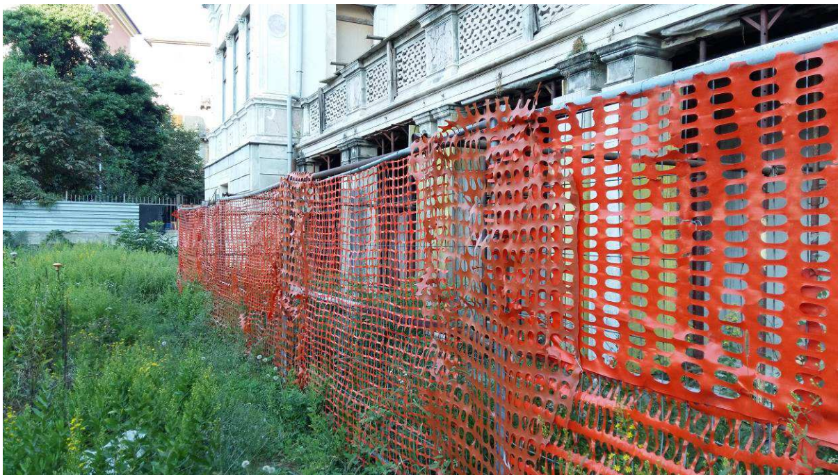
Foto 4) Prospetto sud con protezioni e recinzione.
